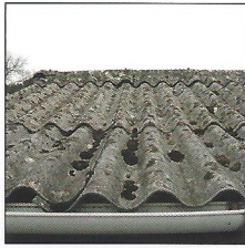
Welleternit und Wellbitumenplatten
