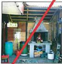
Cheminée im Anbau
